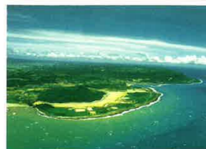
完成基地整地後之空照圖
