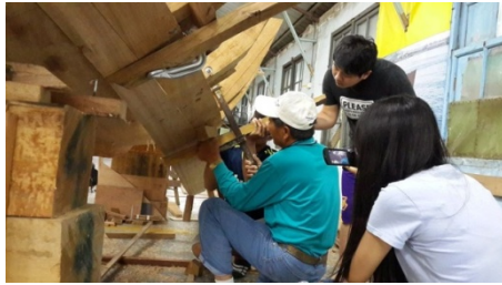
圖 1 安裝船路板的技巧 (攝影／羅國棟)
