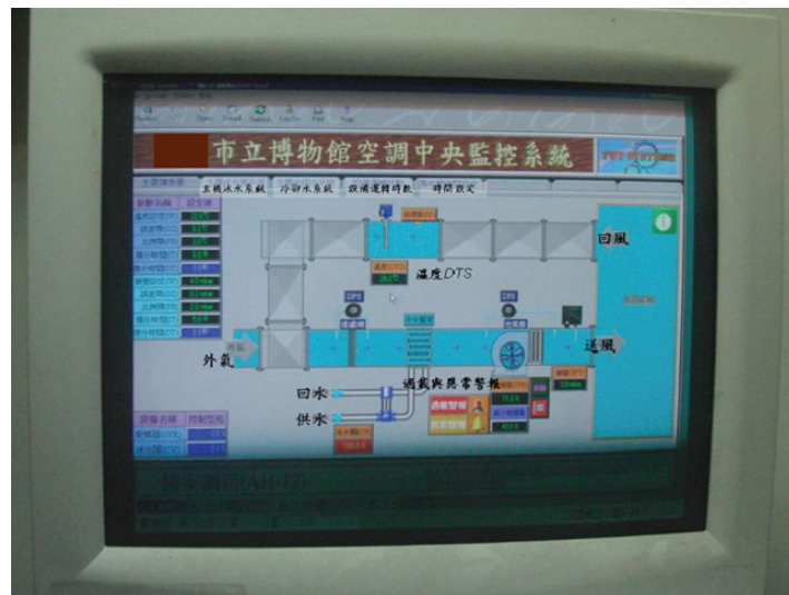
圖2 現場勘察時要了解對方中央空調的運作機制(資料來源：作者拍攝)
