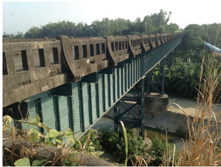
圖 11 官田溪渡槽橋
